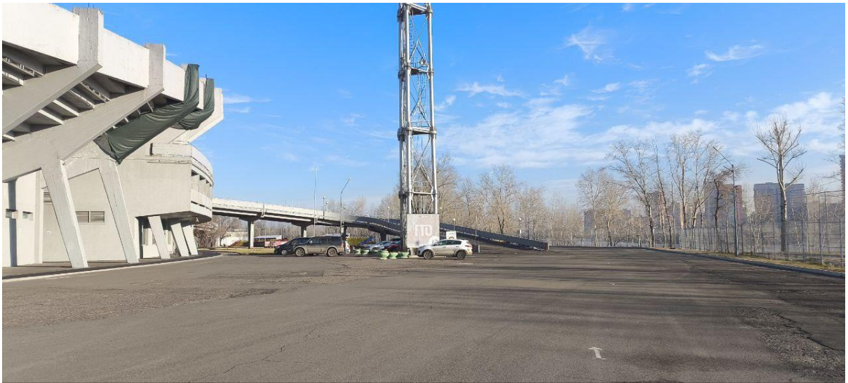
6 Вид с юго-западной стороны. Фото 06.11.2024
