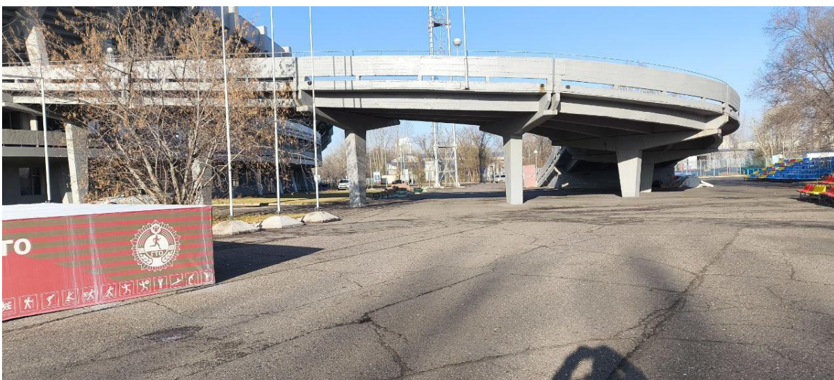
10 Вид с юго-восточной стороны. Фото 06.11.2024
