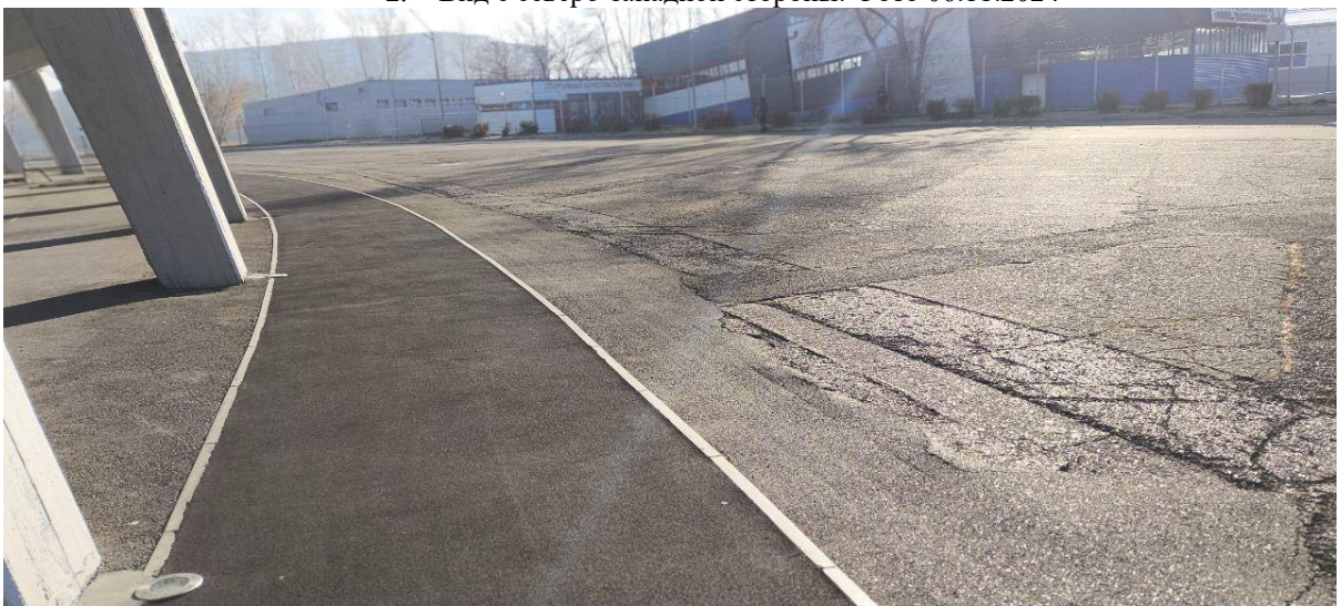
3 Вид с северо-западной стороны. Фото 06.11.2024
