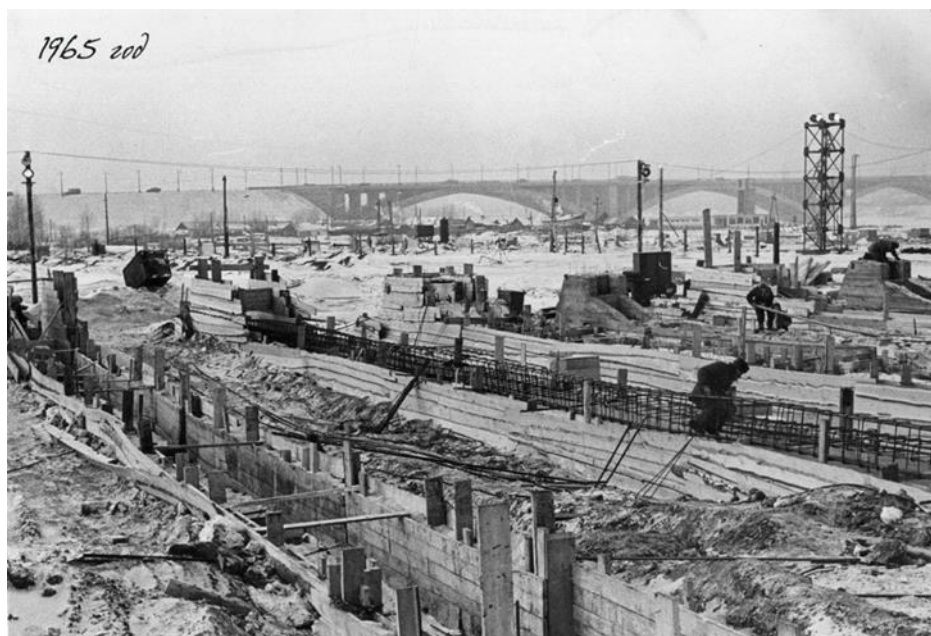
Рис. 10. Строительство стадиона, 1965 г. Электронный ресурс: http://xn----7sbbimrdkb3alvdfgd8eufwc.xn--p1ai/gosudarstvennyi-arkh/users/articles/620?ysclid=lfncz50zc453199917 .
