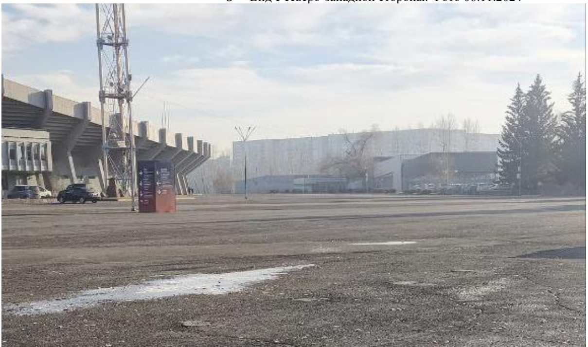
4 Вид с западной стороны. Фото 06.11.2024
