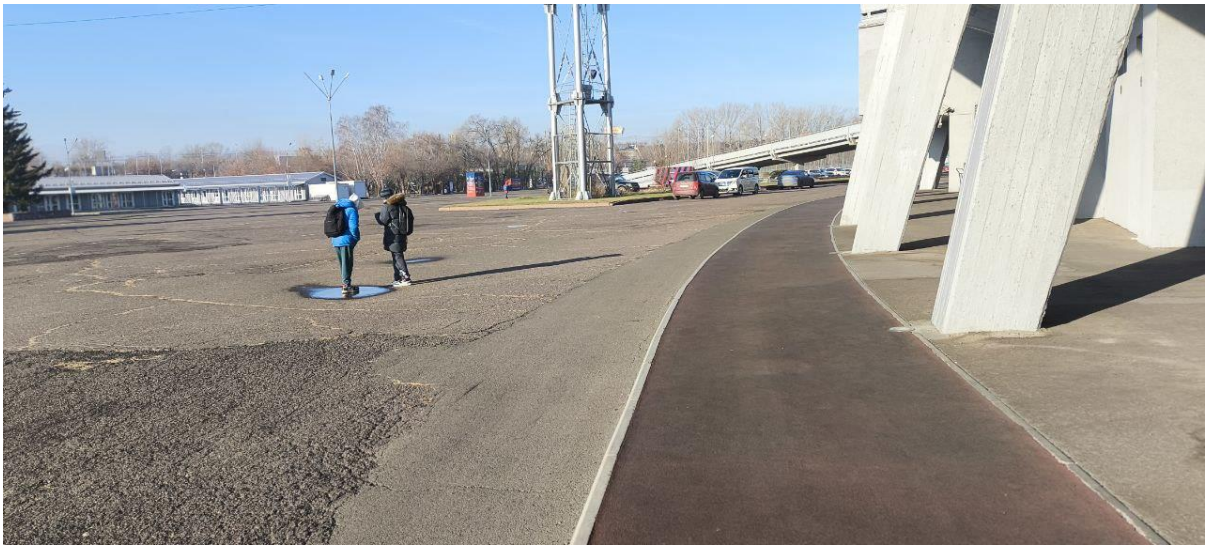
5 Вид с юго-восточной стороны. Фото 06.11.2024
