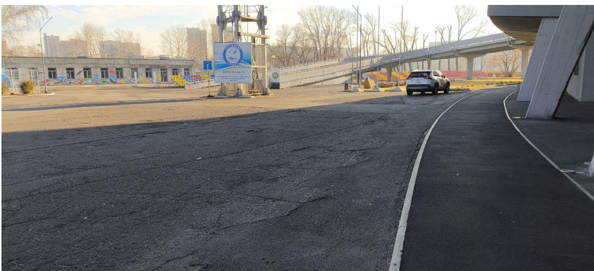
12 Вид с западной стороны. Фото 06.11.2024
