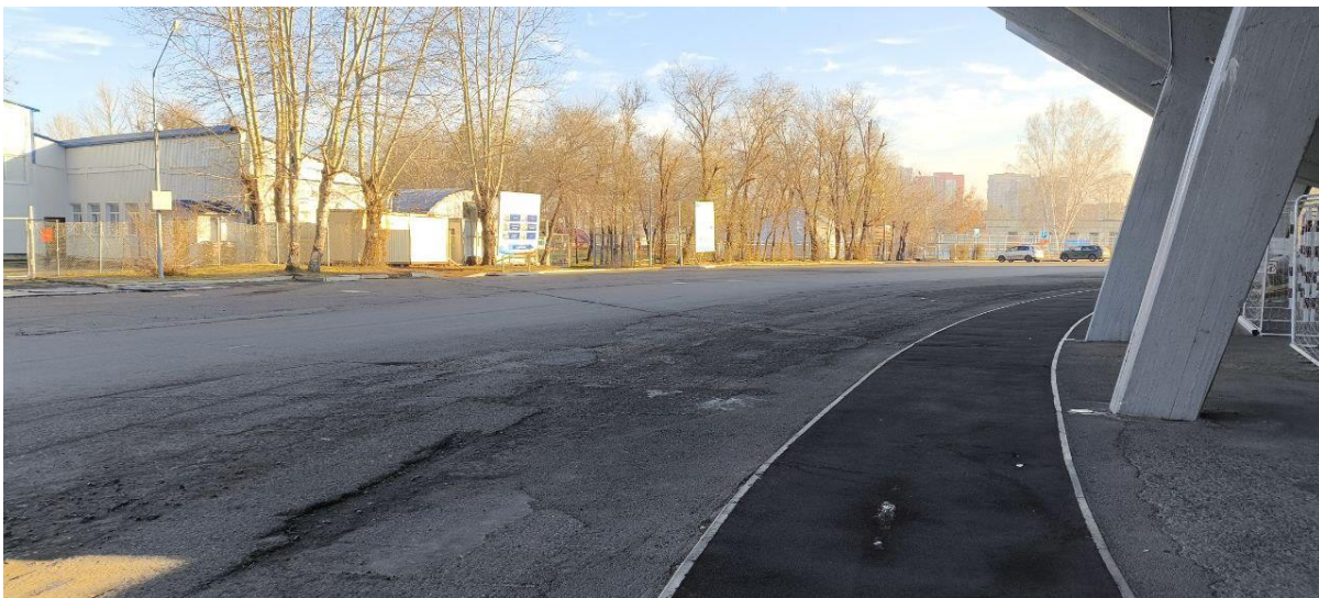
14 Вид с западной стороны. Фото 06.11.2024
