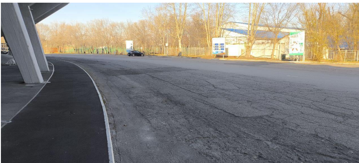
13 Вид с юго-восточной стороны. Фото 06.11.2024
