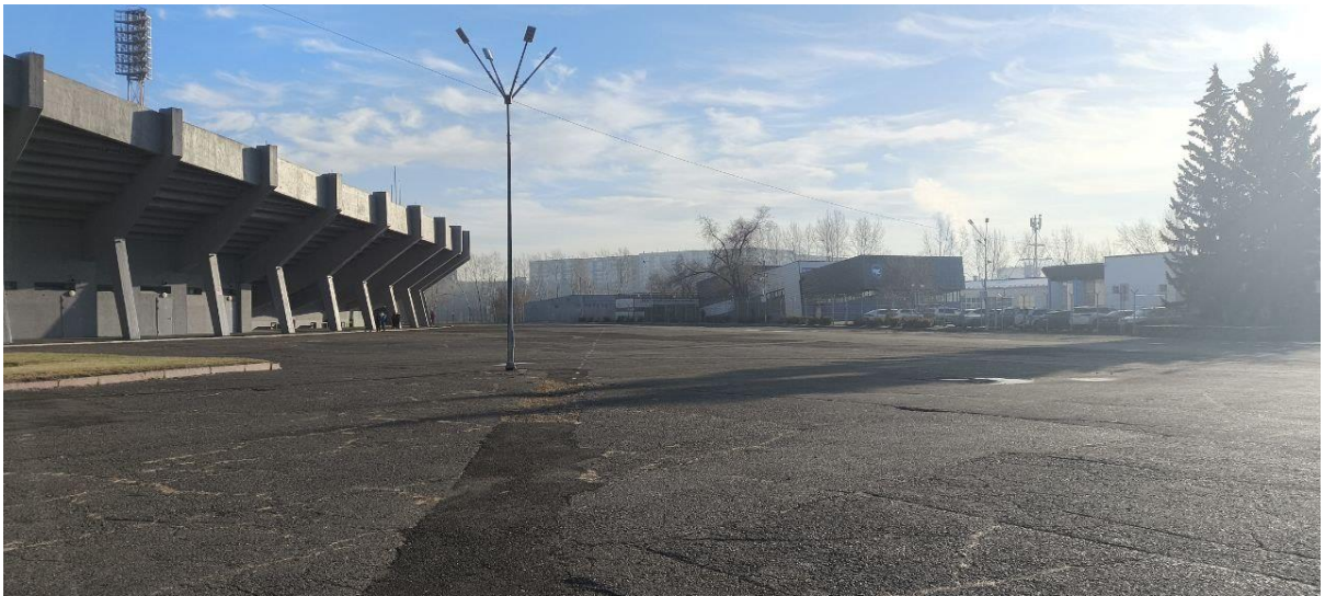
2. Вид с северо-западной стороны. Фото 06.11.2024
