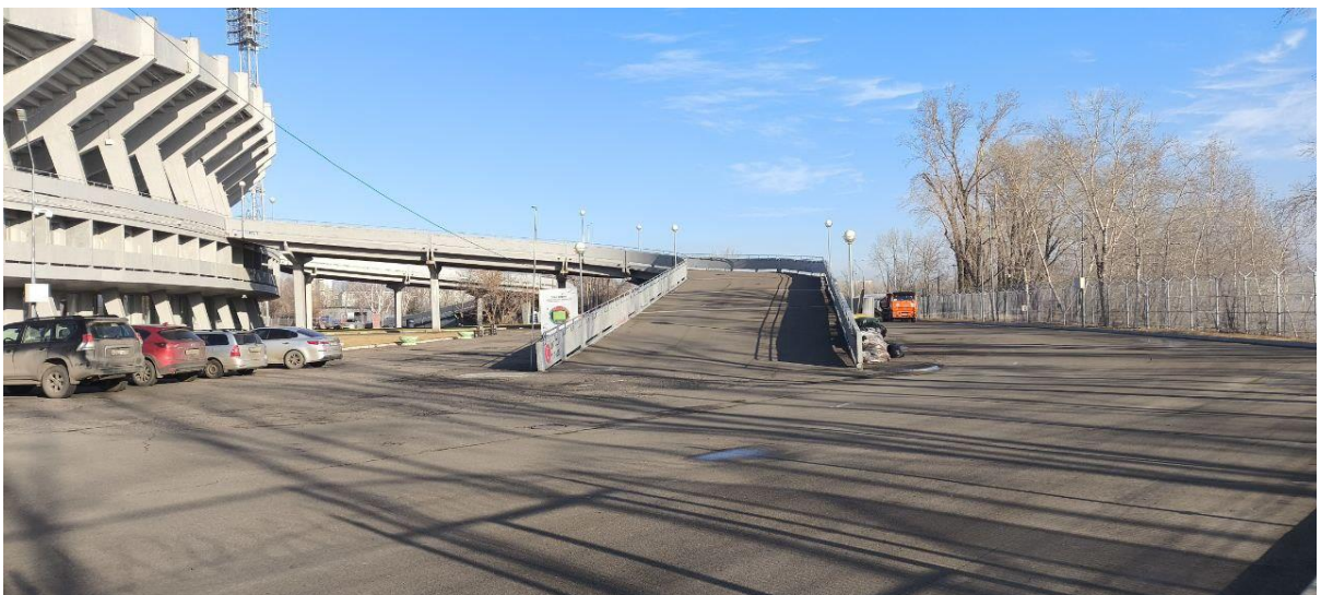
7 Вид с юго-западной стороны. Фото 06.11.2024
