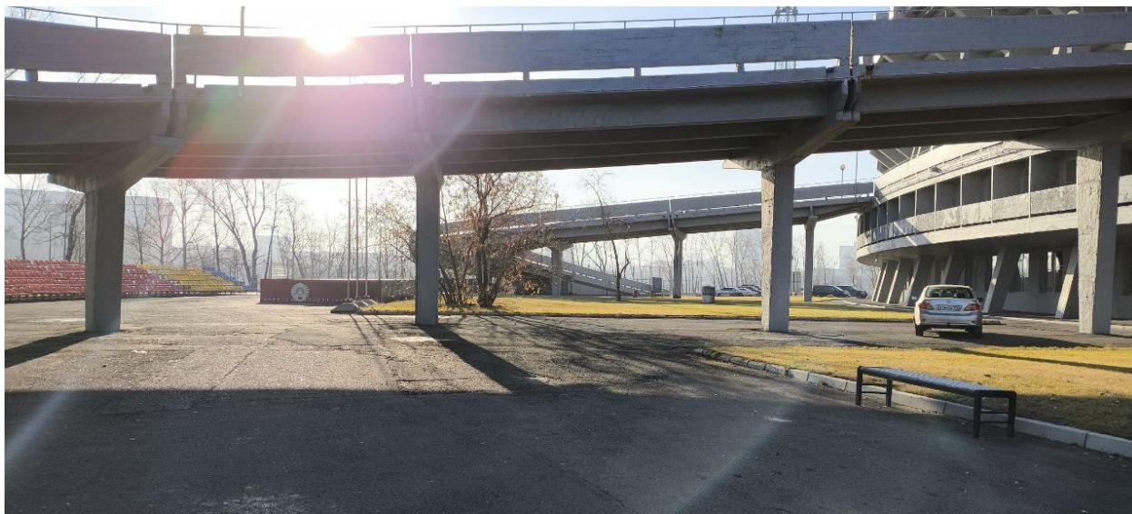
11. Вид с северной стороны. Фото 06.11.2024
