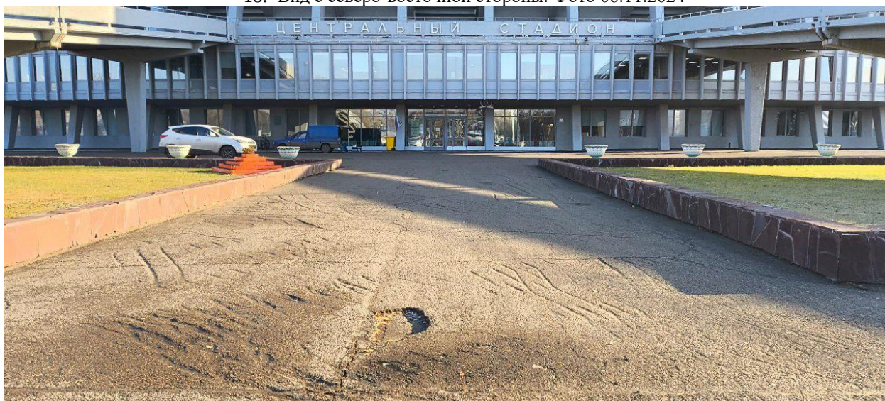
19. Главный вход. Вид с западной стороны. Фото 06.11.2024.
