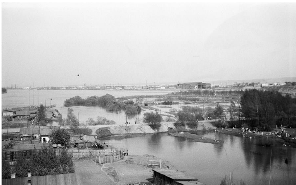
Рис. 9. Место строительства будущего стадиона за год до начала работ. Электронный ресурс: http://newslab.ru/photo/723968 .
