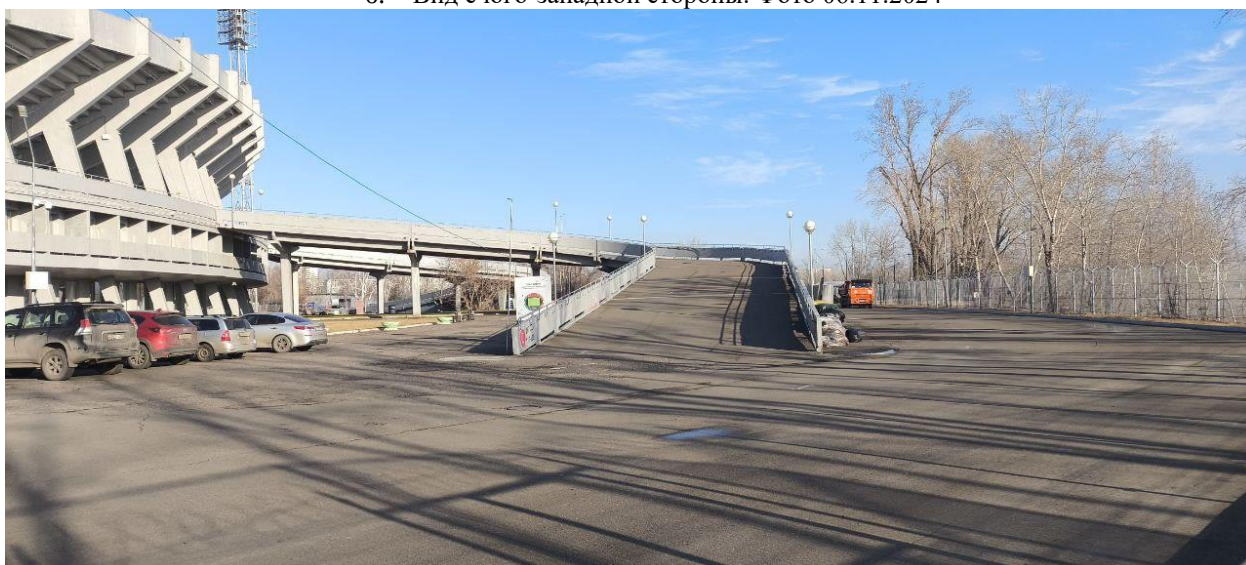
7. Вид с юго-западной стороны. Фото 06.11.2024
