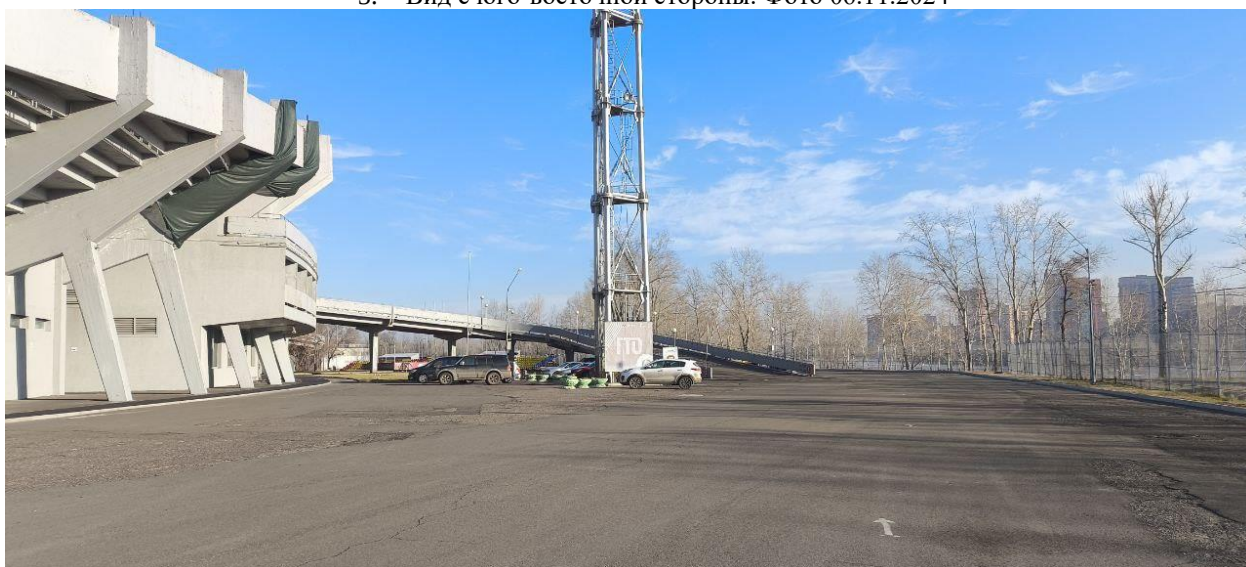
6. Вид с юго-западной стороны. Фото 06.11.2024
