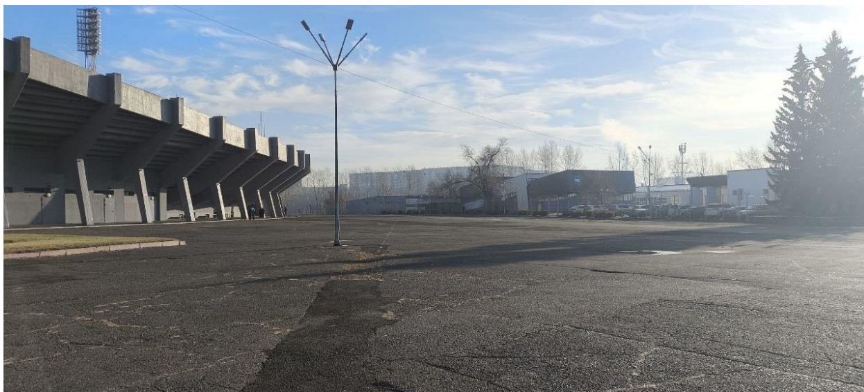
2. Вид с северо-западной стороны. Фото 06.11.2024
