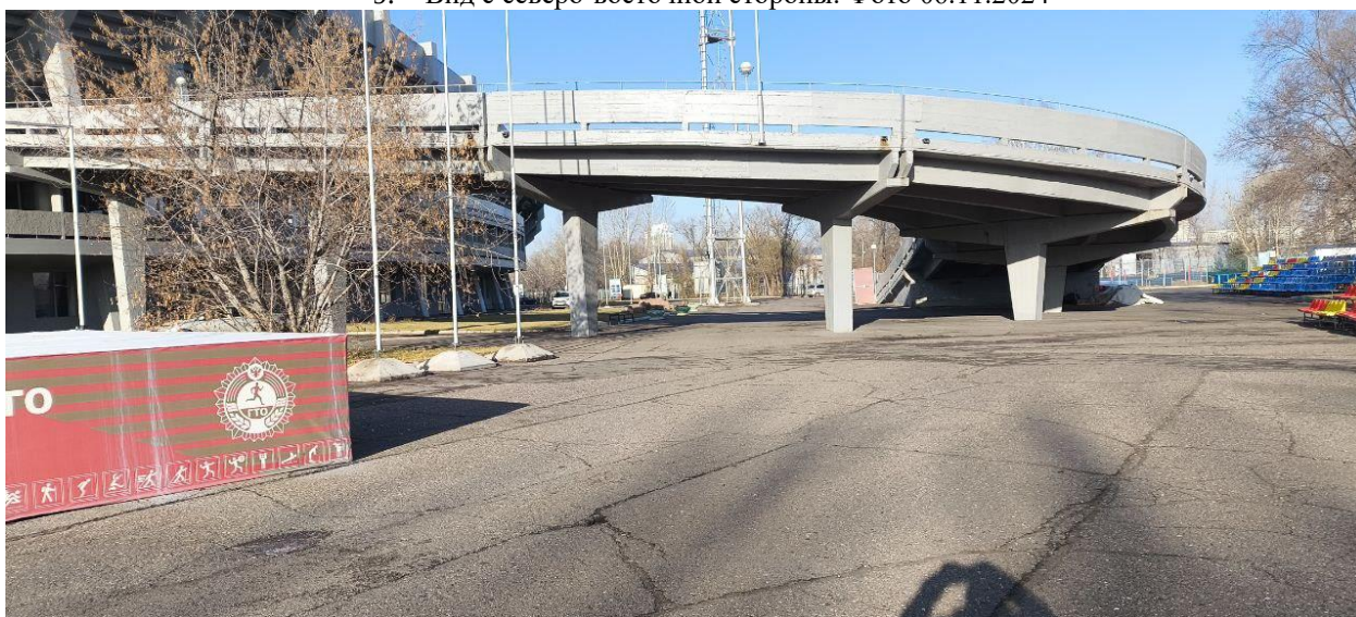
10. Вид с юго-восточной стороны. Фото 06.11.2024
