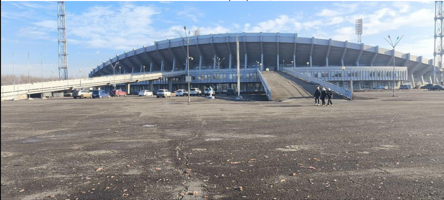
1. Вид с юго-западной стороны. Фото 06.11.2024
