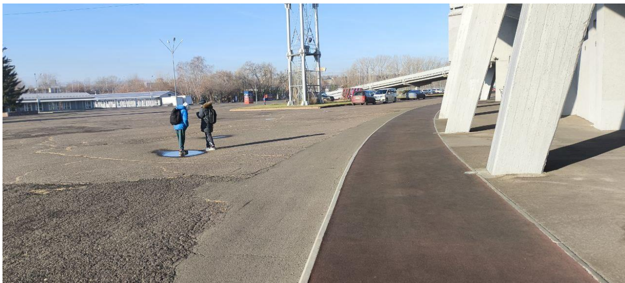
5. Вид с юго-восточной стороны. Фото 06.11.2024
