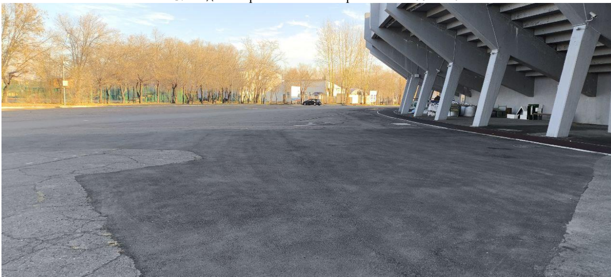
16. Вид с юго-западной стороны. Фото 06.11.2024
