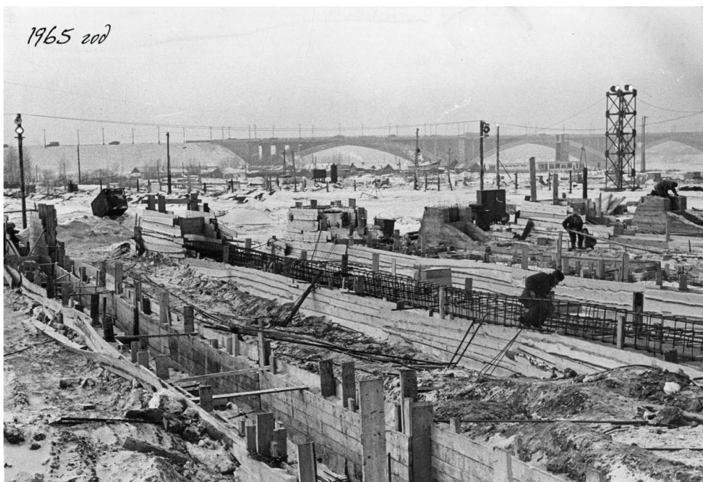
Рис. 12. Строительство стадиона, 1965 г. Электронный ресурс: http://xn----7sbbimrdkb3alvdfgd8eufwc.xn--p1ai/gosudarstvennyi-arkh/users/articles/620?ysclid=lftncz50zc453199917 .
