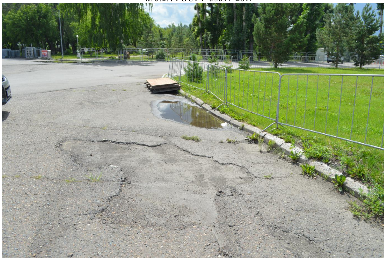
Наличие выбоин размерами 100 x 50 см глубиной до 4 см, что не соответствует требованиям п. 5.2.4 ГОСТ Р 50597-2017
