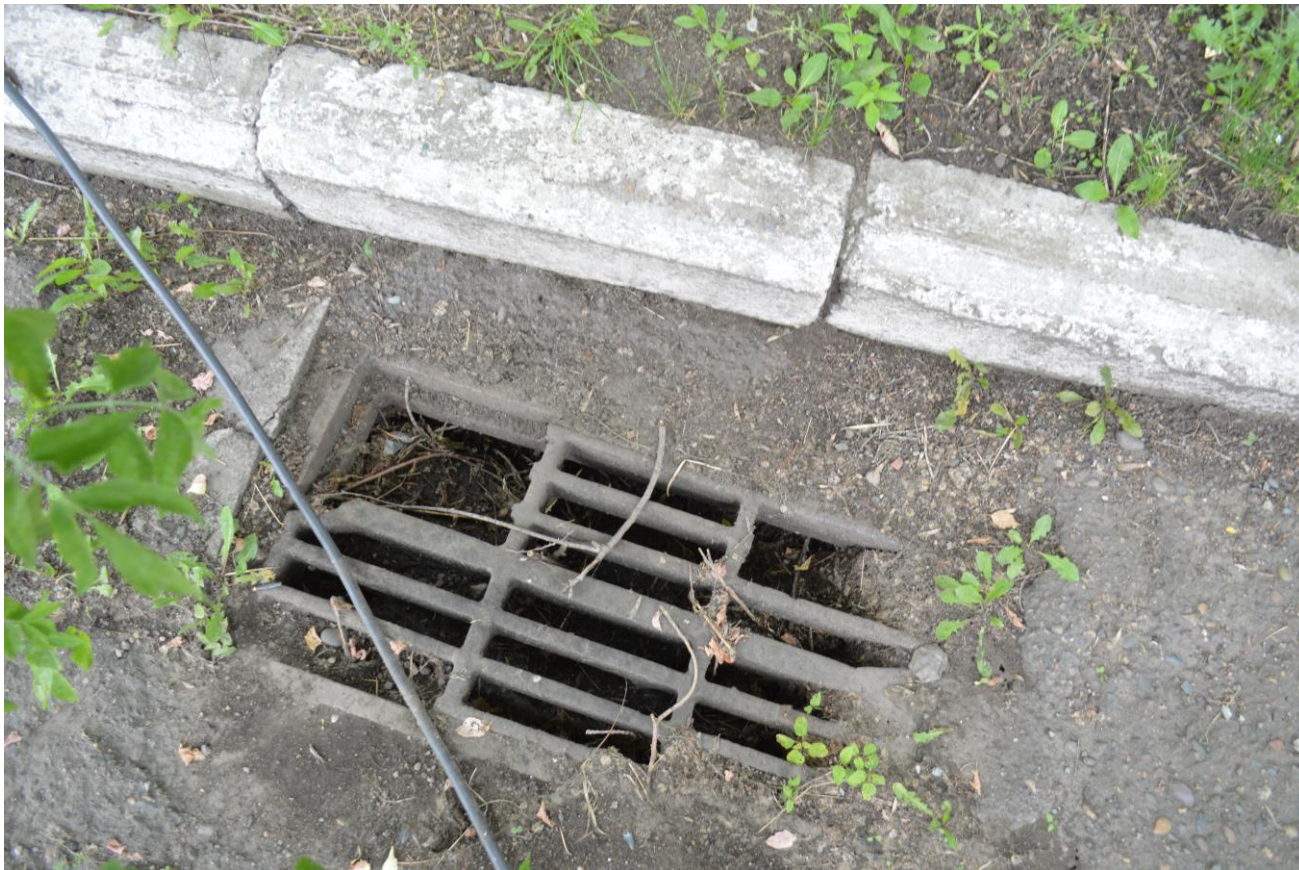
Разрушение горловин дождеприемных колодцев, что не соответствует требованиям ГОСТ Р 50597-2017
