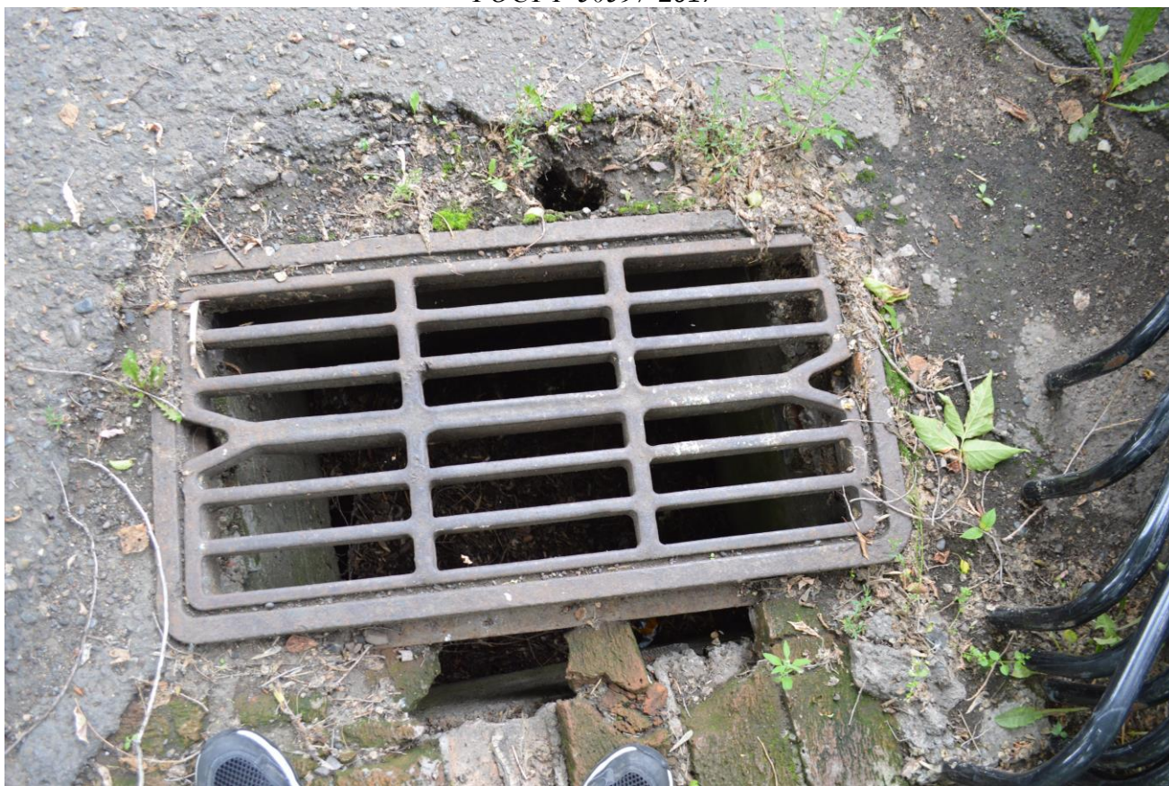
Разрушение горловин дождеприемных колодцев, что не соответствует требованиям ГОСТ Р 50597-2017
