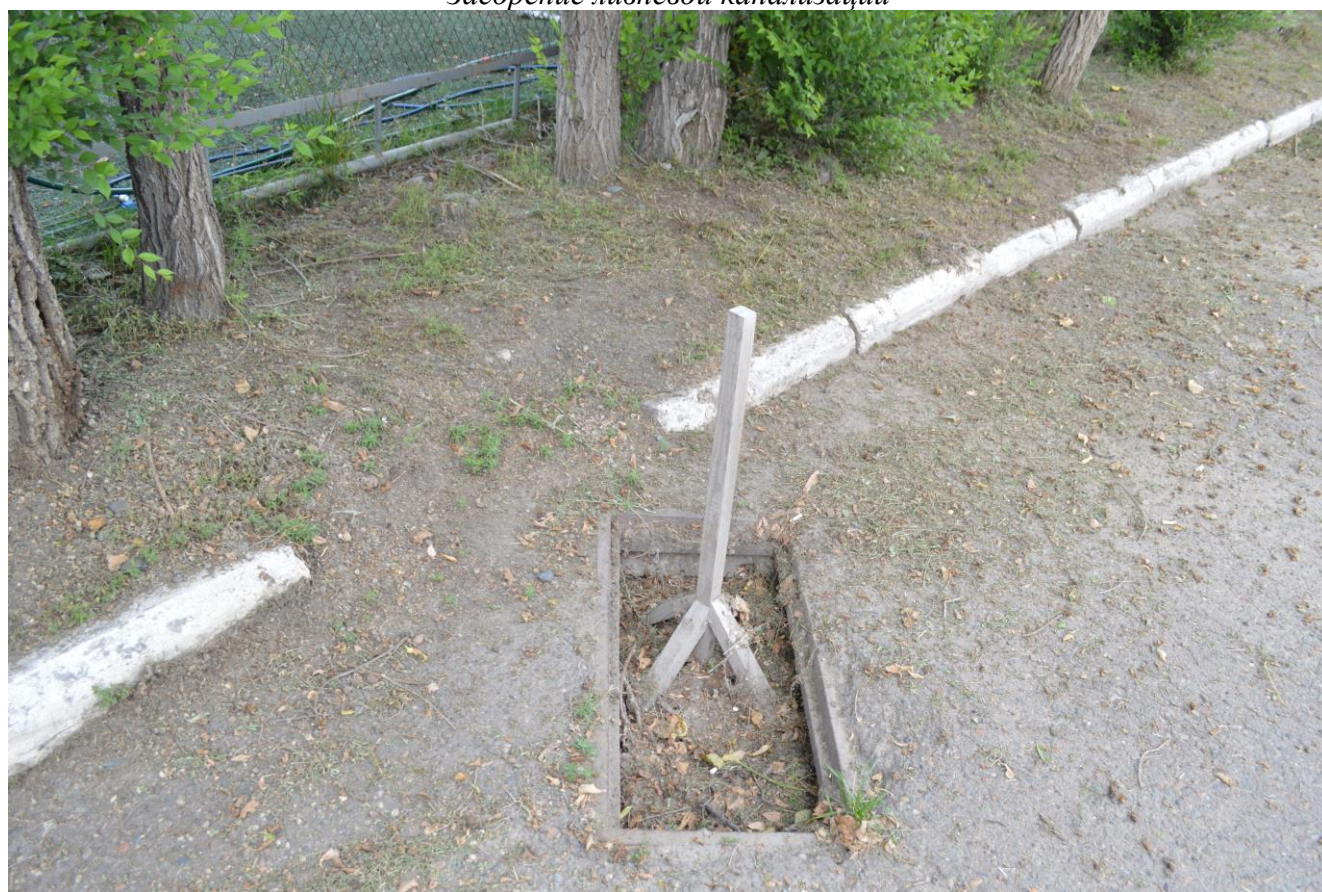
Засорение ливневой канализации
