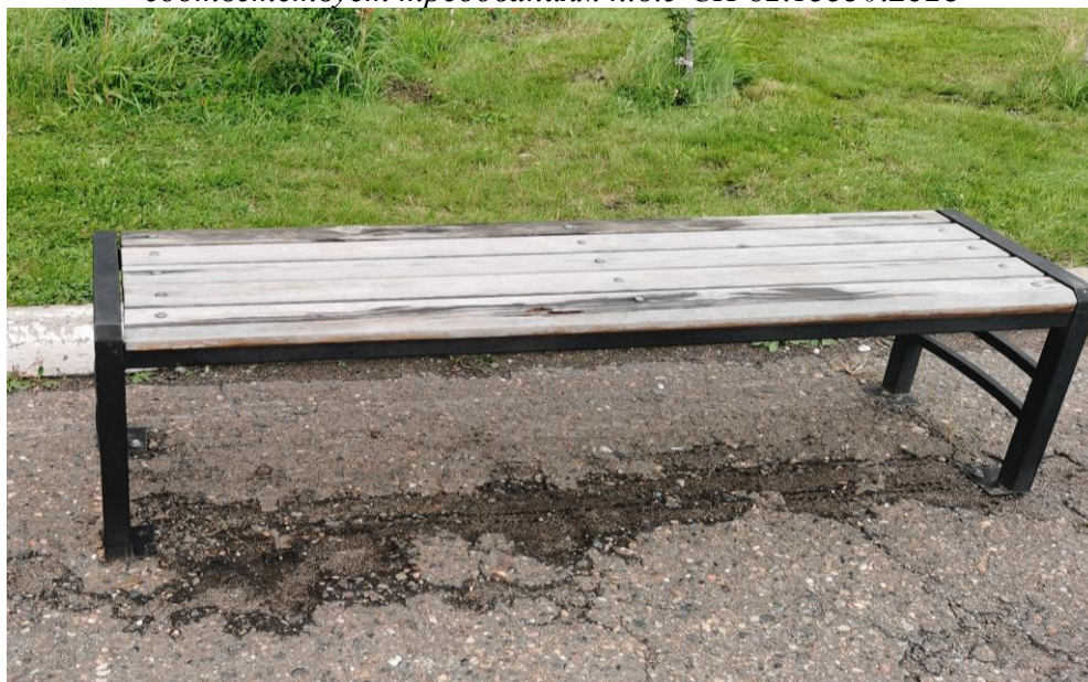
Зафиксированы дефекты элементов благоустройства, гниение древесины скамьи, что не соответствует требованиям п.8.5 СП 82.13330.2016
