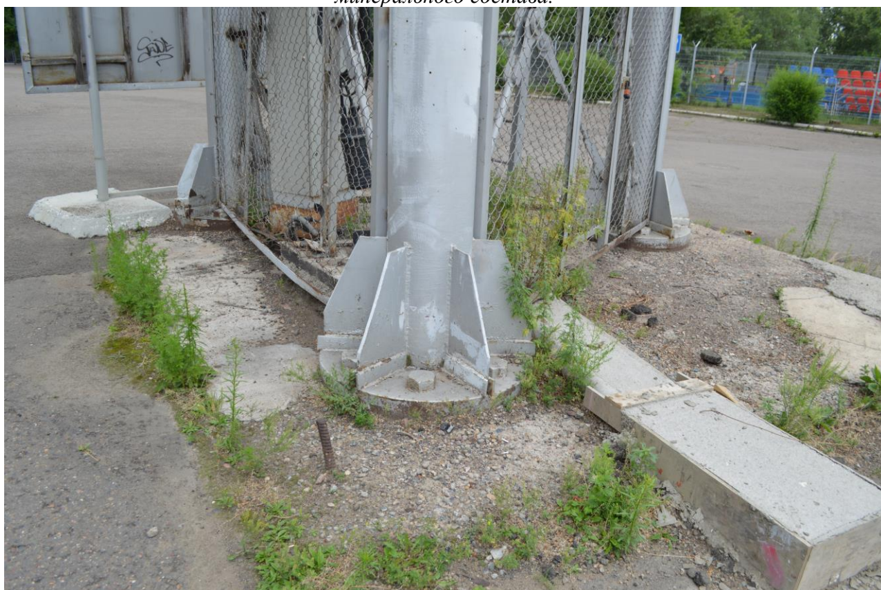
Бетонное покрытие у мачт освещения имеет трещины, сколы, отделение зерен минерального состава.
