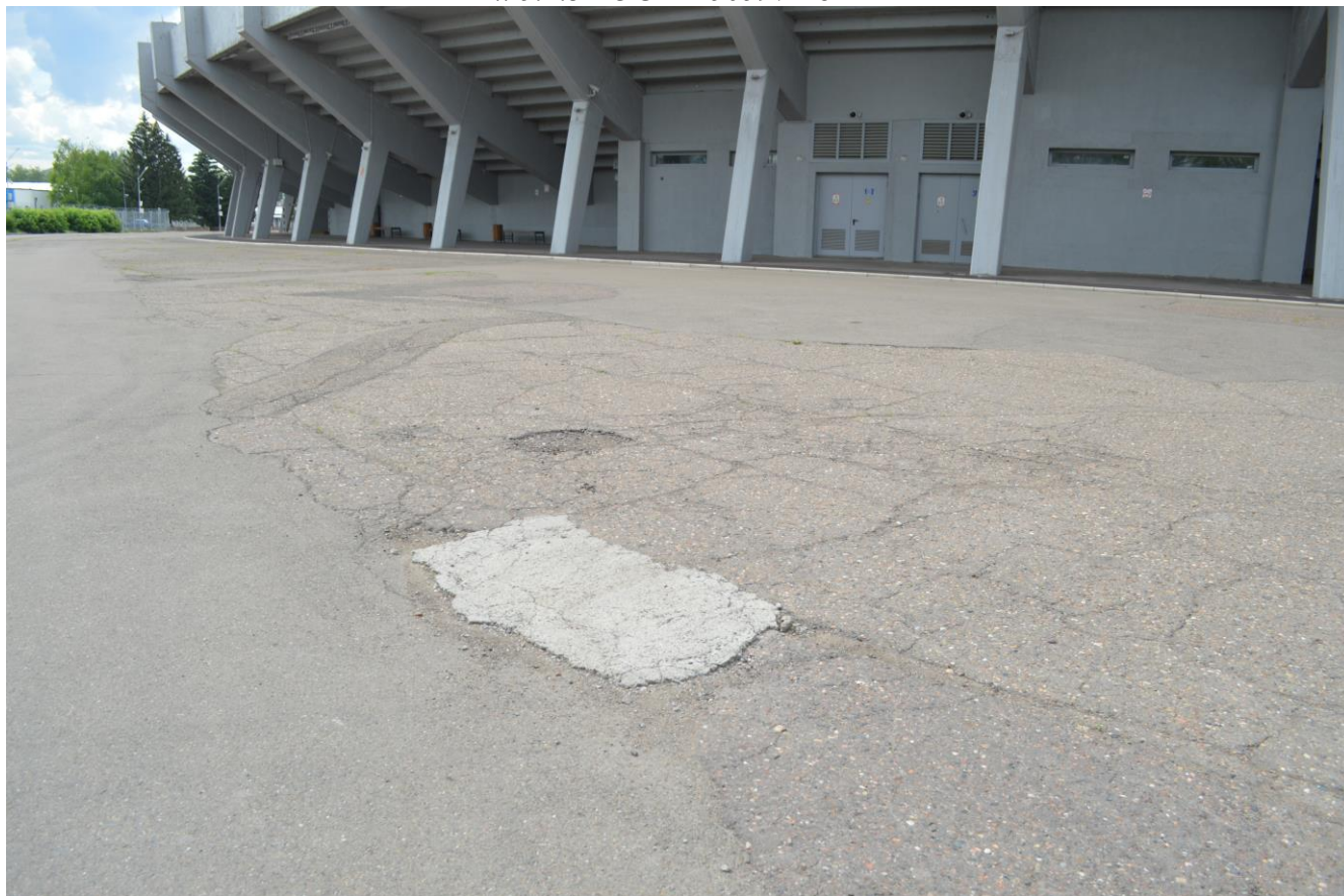
Наличие выбоин размерами 100 x 50 см глубиной до 4 см, что не соответствует требованиям п. 5.2.4 ГОСТ Р 50597-2017
