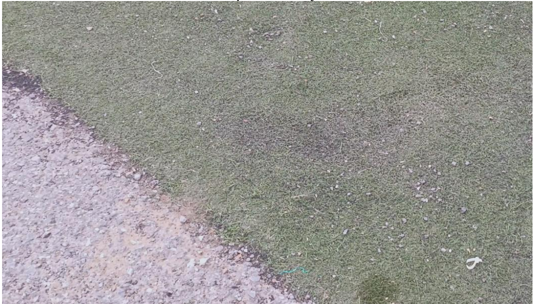
Частичный износ покрытия искусственного газона
