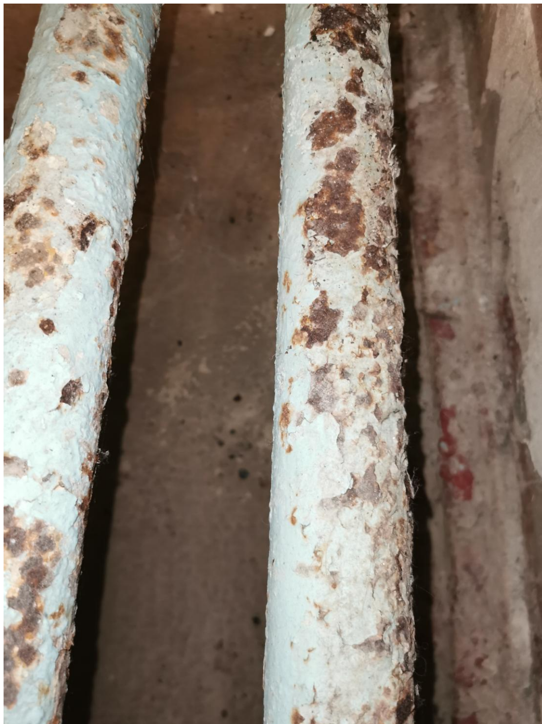
Фото 6. Коррозия магистральных трубопроводов.
