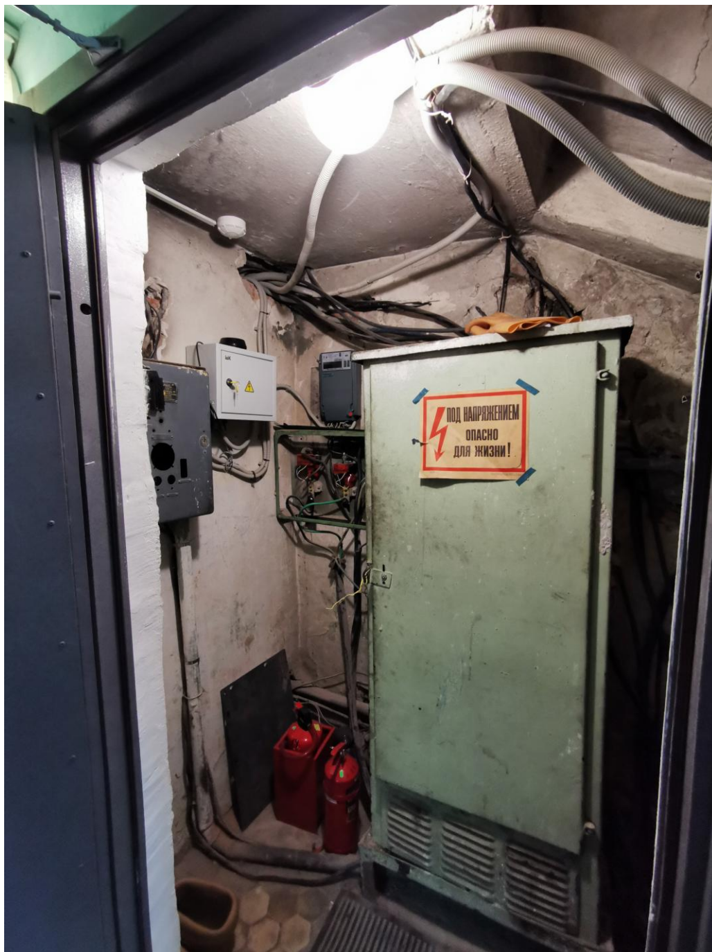
Фото 8. ВРУ, износ электрических сетей.
