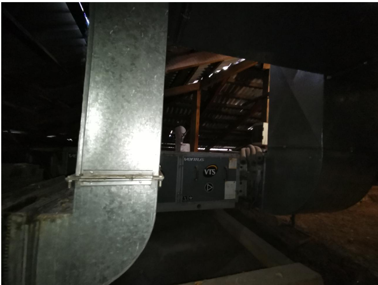
Фото 9. Воздуховоды без изоляции на чердаке.
